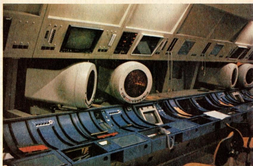
*La nouvelle salle de contrôle, au centre régional d'Aix-en-Provence : chaque « poste » est équipé d'écrans radar à fonctions multiples, de fréquences radio et de lignes directes avec tous les terrains et tous les centres adjacents, ainsi que de circuits de télévision qui distribuent toutes les informations nécessaires au guidage, et notamment en situation météorologique. 23 X 1981 (Photo « Nice-Matin »)*
