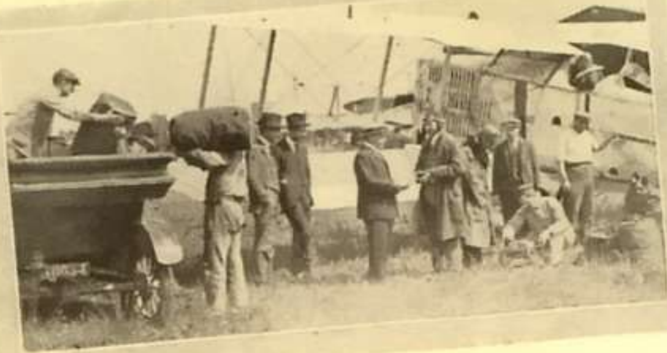
Chargement de poste.
